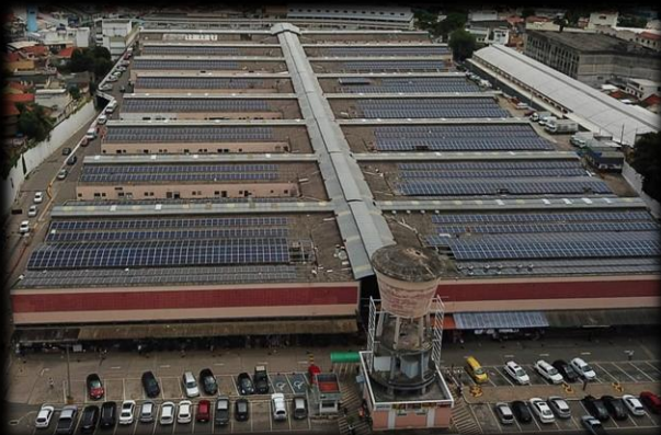
CPFL - OBRA CADEG - RJ
